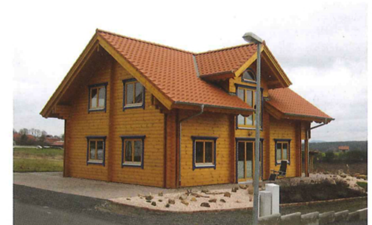
▲ Tyypillinen Saksaan menevä omakotitalo, joka on tehty 95 mm:n sydänhalkaistusta hirrestä.
